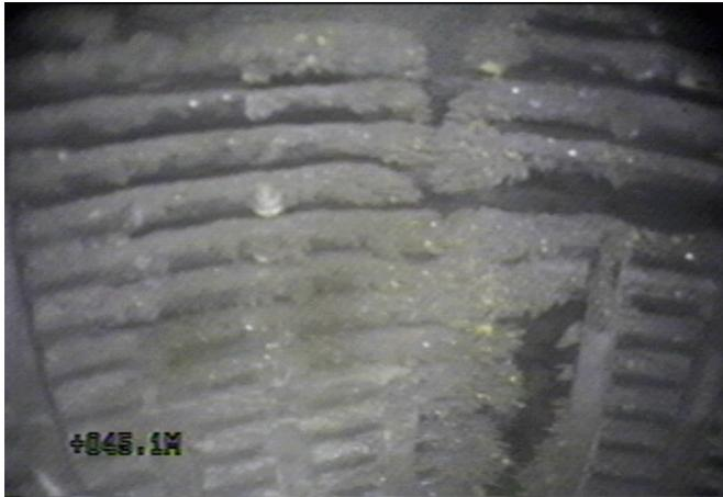
Foto 1. Rejillas rotas por mantenimiento inapropiado.
